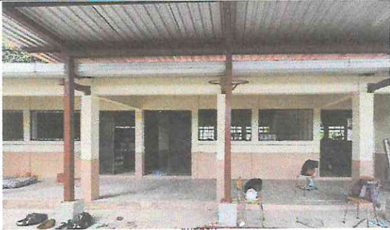
Foto 2: PINTURA EN MUROS INTERIOR Y EXTERIOR Preparación de la superficie y aplicación de pintura a dos manos, en paredes interiores y exteriores del establecimiento.
