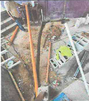
Foto 4:REPARACIÓN DE RED DE DRENAJES Y RED DE AGUA POTABLE Sustitución de tuberías PVC para redes hidráulicas de drenaje, adherencia entre cortes, uniones de tubería y accesorios con pegamento PVC
