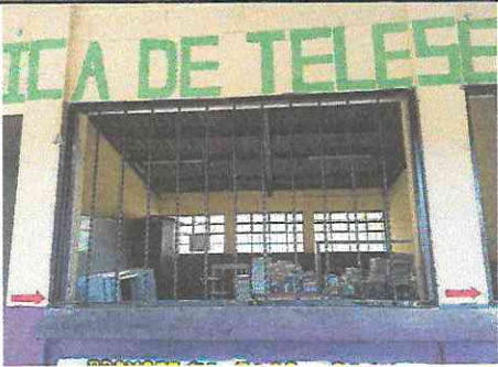
Foto1: VENTANAS Sustitución de ventanas; sistema de apertura: Corredizas, Perfiles color blanco estandar, Material del marco: PVC Material de la ventana: Vidrio, sellado perimetral. Aula 1 y 2
