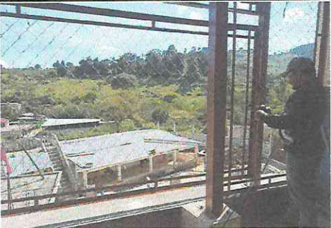
Foto 5: CERCO O MURO PERIMETRAL Sustitución malla de acero galvanizado en perímetro del establecimiento, con instalación fija y tensa, anclajes metalicos en intervalos regulares
