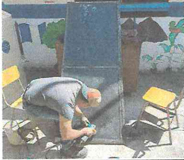
Foto 6: PUERTAS Mantenimiento a puerta metálica existente retiro de óxido, suciedad y pintura deteriorada; incluye cepillado, lijado y aplicación de pintura. Aula 1,2,3
