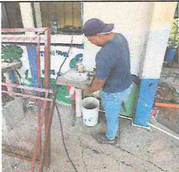
Foto 3:SERVICIOS SANITARIOS Y SUS ACCESORIOS Sustitución de lavamanos, accesorios y conexiones.
